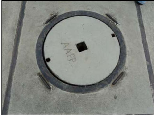
**FOTOGRAFÍA 3.5. CÁMARA DE REGISTRO DE AGUA POTABLE**
